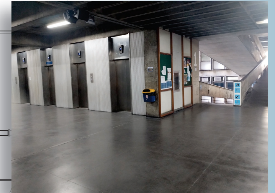
Hall dos Elevadores
