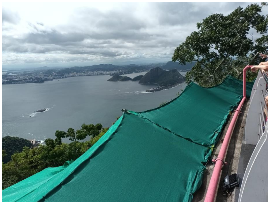
Vista do topo – lona verde encobrindo as obras em andamento
