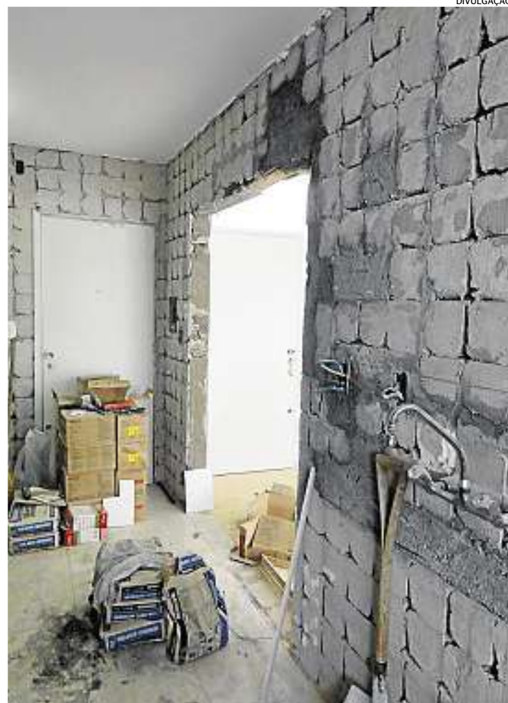
Obra em andamento: cronograma deve ser entregue a condomínio
