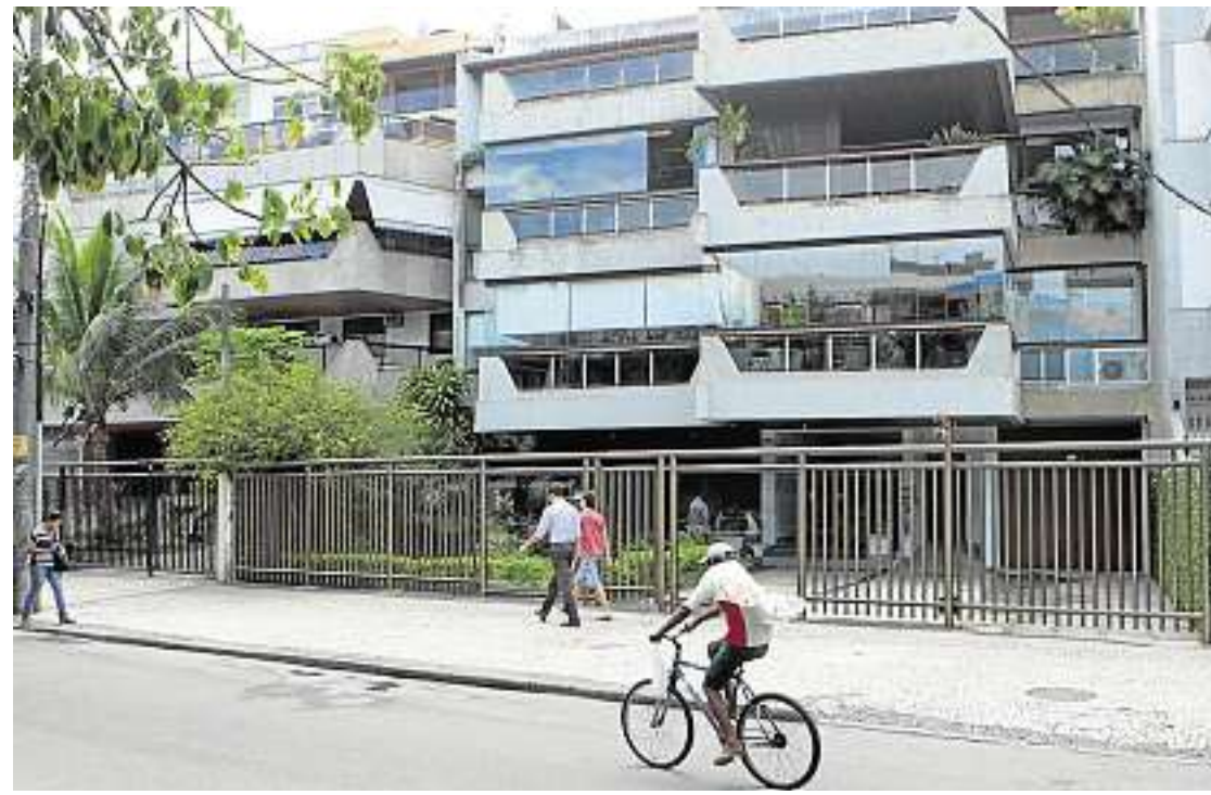
Isolamento. Prédio no Jardim Oceânico: para moradores, a varanda fechada protege contra chuva e poluição
