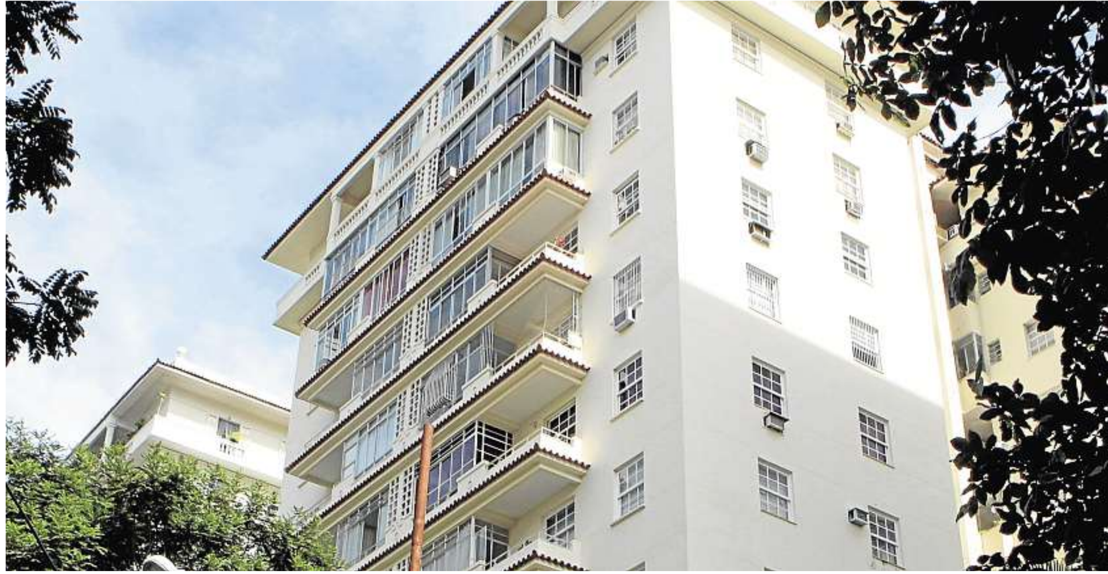
Cada um por si. Fachada de um prédio na Rua General Glicério, em Laranjeiras: a falta de critério faz com que cada morador decida como vai fechar sua varanda, fazendo com que o projeto arquitetônico do edifício seja prejudicado
