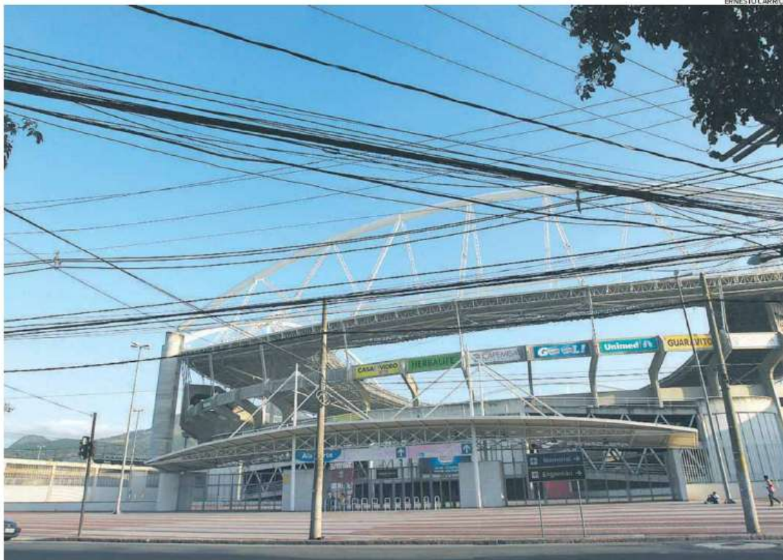
O emaranhado de fios nas imediações do Engenhão: área será uma das próximas a receber o novo sistema de dutovias com fibras óticas
