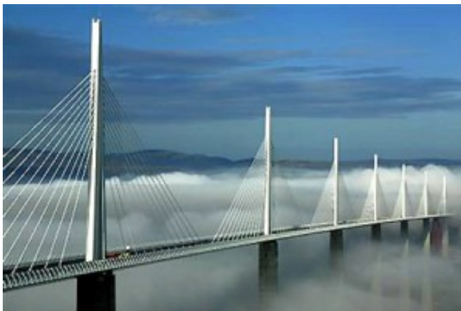
Viaduto Millau, Millau, França
